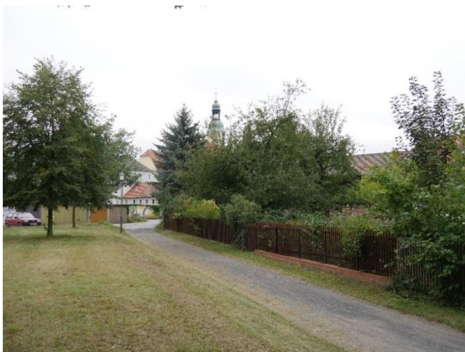
Hausgärten der Wohnbebauung Edmund-Kretschmer-Straße (rechts) und Beginn des Hochwasserschutzdammes am Turbinengraben (links)
