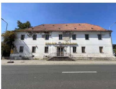
ehem. Gaststätte „Stadt Dresden“
