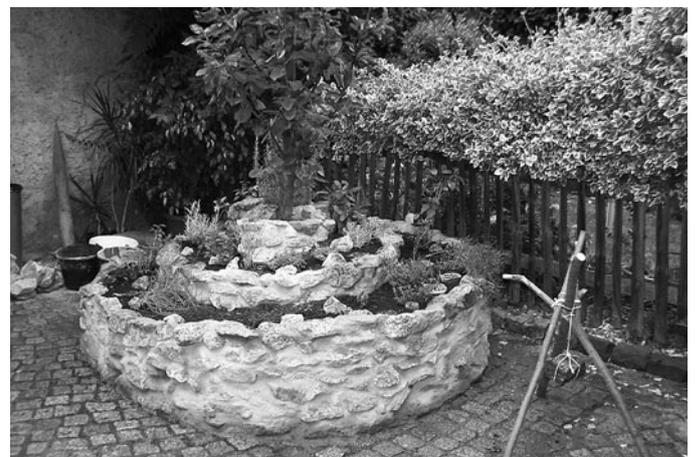
So strebte das Bauwerk mit maximal einer Schicht Steine pro Tag seiner Endfertigung entgegen. Die Krone dauerte noch etwas länger, da hier jeder Stein passen musste. Mit dem Resultat zufrieden, ging es an das Verschmieren der später sichtbaren Fugen. Mit der Fertigstellung konnten nun auch die letzten Fragesteller nicht mehr hinter das Licht geführt werden, zumal zeitnah die Befüllung mit Erde begann.
