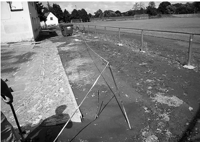
Sportplatz nach Abzug des Hochwassers
