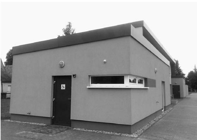
Sportplatz – Funktionsgebäude nach Fertigstellung
