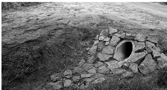
Ansicht eines neu gestalteten Durchlasses
