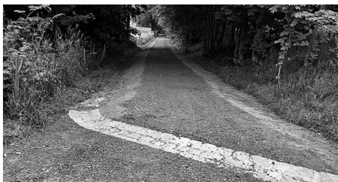
Ansicht des oberen Wegeabschnitts mit dem Gefälle angepassten und gepflasterten Abschlager
