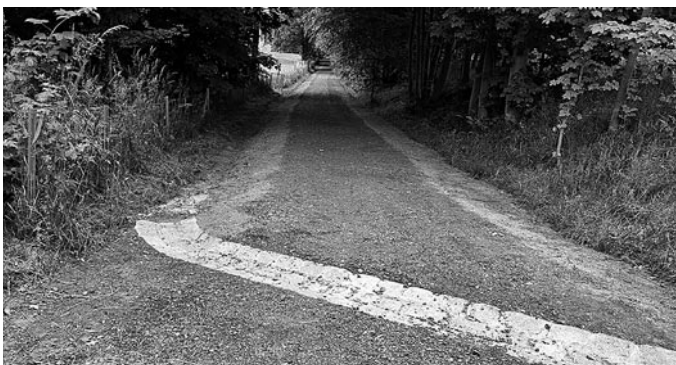
Ansicht des oberen Wegeabschnitts mit dem Gefälle angepassten und gepflasterten Abschlag
