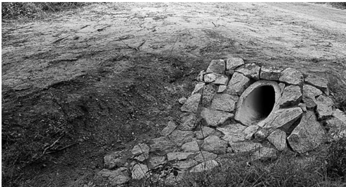
Ansicht eines neu gestalteten Durchlasses
