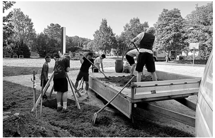
Basketballplatz-Bau · Foto: Sebastian Rikl
